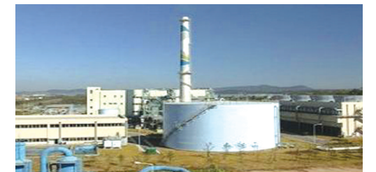
〈현재 매립가스발전소 가동중(50MW)〉
